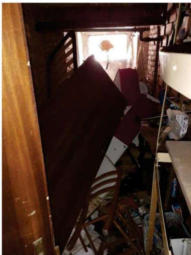
FOTOGRAFIA 20 - CANTINA AL PIANO INTERRATO
